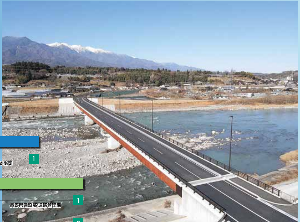
主要地方道伊那生田飯田線 松川町 宮ヶ瀬橋
