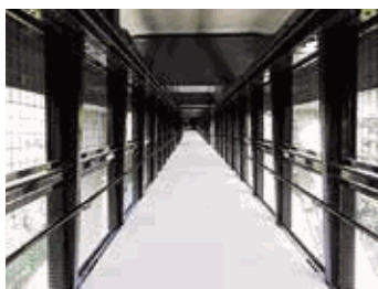
添架歩廊(そらさんぽ天龍峡)内部
