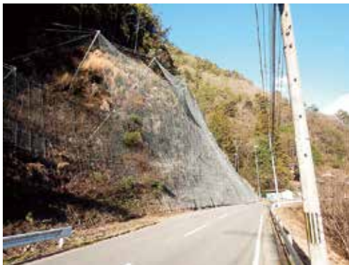
法面対策の状況(飯田市)
