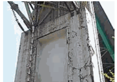
(橋梁老朽化の状況)
