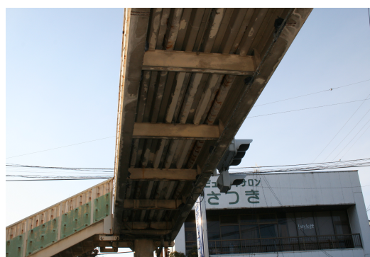
鋼床版の広い範囲で腐食が認められる。
