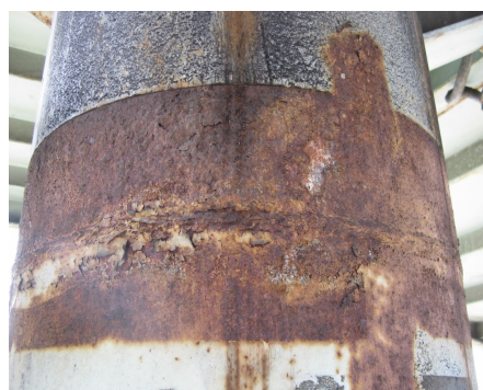
橋脚に著しい腐食が認められる。
