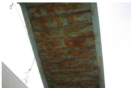
鋼板に発錆あり、劣化著しい。
