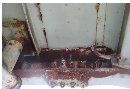
連結部に著しい腐食が認められる。
