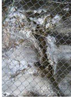
【写真4】剥落状況
