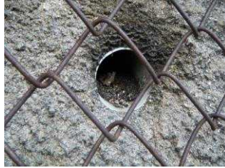
【写真2】水抜きパイプ状況
