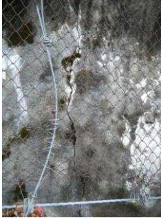
【写真1】ひび割れ状況
