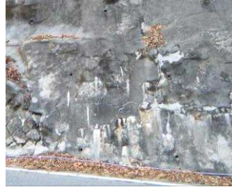
【写真5】ひび割れ状況
