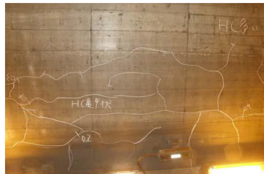
写真 1.6 複数のひび割れで覆工コンクリートがブロック化している例 1)
