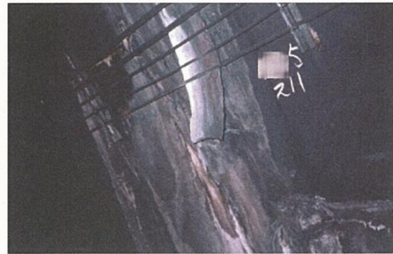
写真 1.10 補修モルタルが劣化してはく離している例 1)
