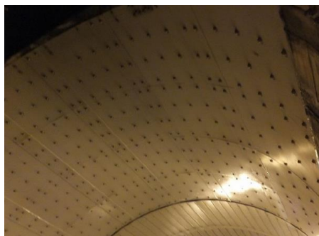
写真 1.11 鋼板接着；左・繊維シートの接着；右の例 1)
