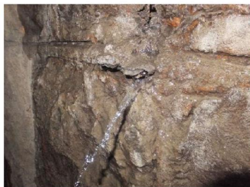
写真 1.8 漏水（噴出）している例 1)
