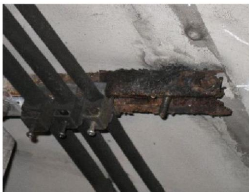
写真 1.13 固定金具の腐食とアンカーボルトの脱落の例 1)
