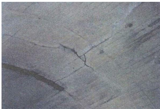
写真 1.6 複数のひび割れで覆工コンクリートがブロック化している例 1)
