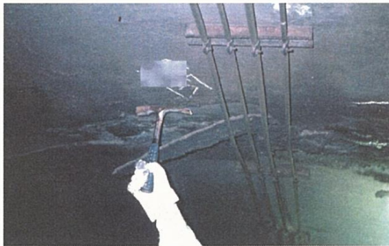
写真 1.10 補修モルタルが劣化してはく離している例 1)
