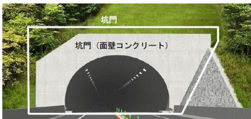
図 1.2 点検対象箇所（トンネル坑口部） 1)
