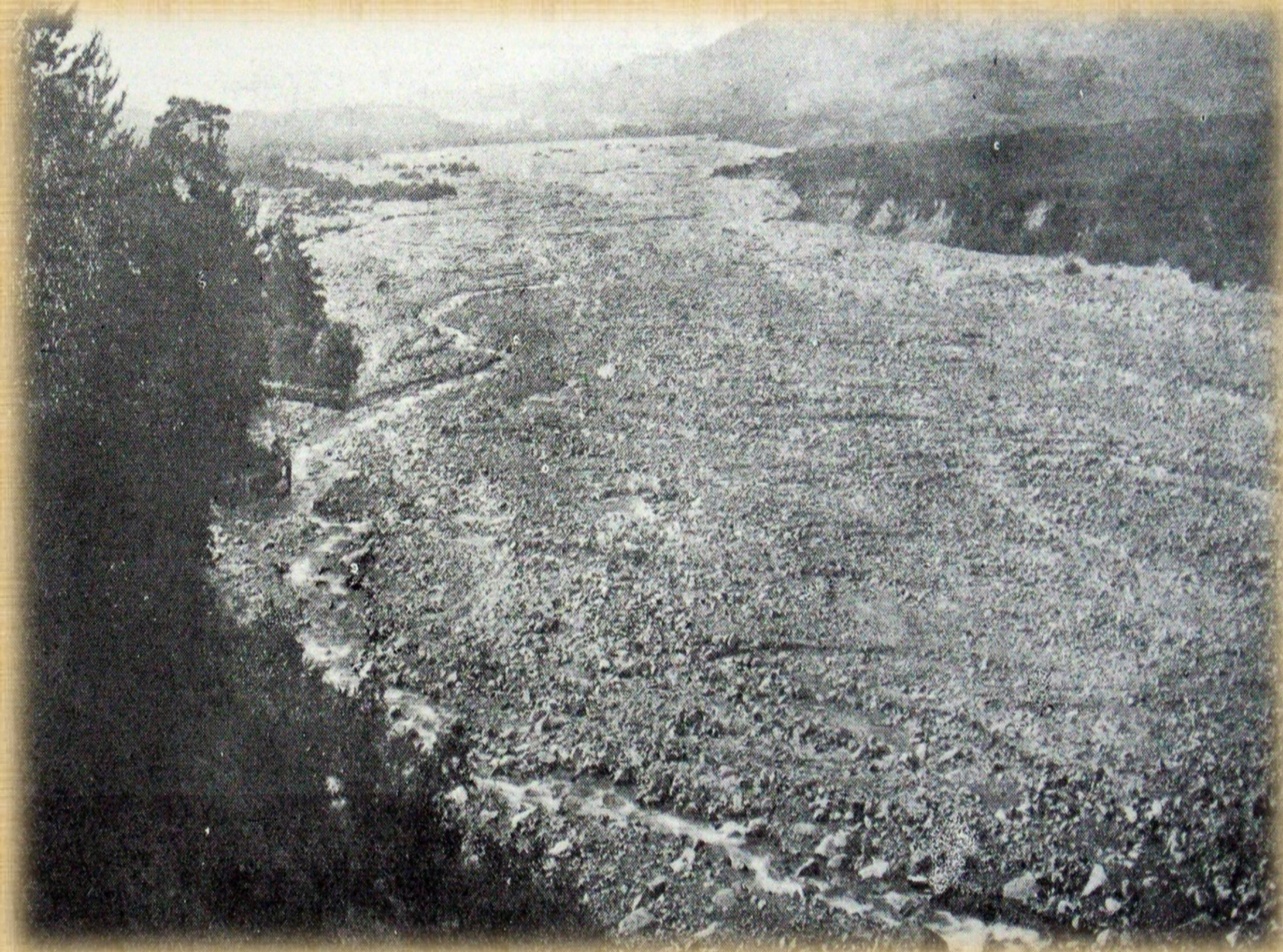
牛伏橋より下流を望む 明治35年(1902)撮影
