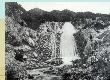
階段工施工前 (内務省1号堰堤下流) 堰堤下流が大きく洗掘され、河床低下の様子がうかがえる。(M45)
