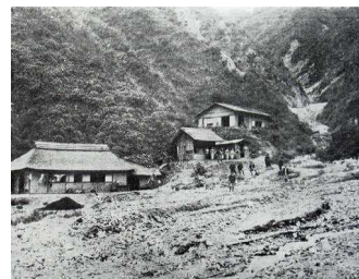
▲砂防工事事務所（M32、悪沢合流点付近）
