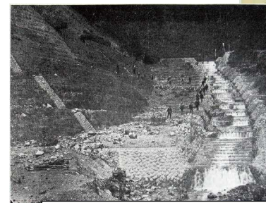
階段工完成後 右岸は盛り立て、斜直には杭柱、張石水路が施工されている。
