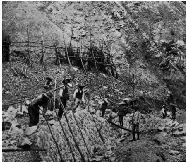
写真3.4.15 石積みの施工(丁張)や上部の安全柵の設置(『沿革史』)
