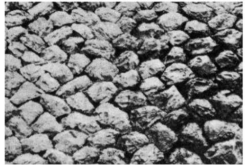
写真3.4.9 県砂防工事の石積
