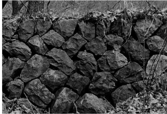
写真3.4.6 石積の石材形状（階段工）
