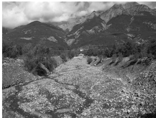
写真1.2.4 サニエル溪下流部の溪流保全工を下流側から望む (2004年著者撮影)
