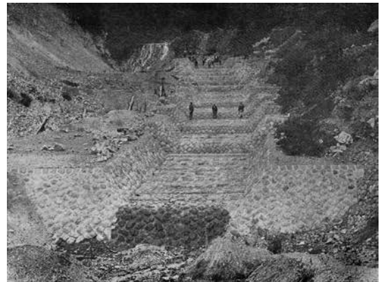
写真1.1.8 階段工施工中の状況（『沿革史』）
