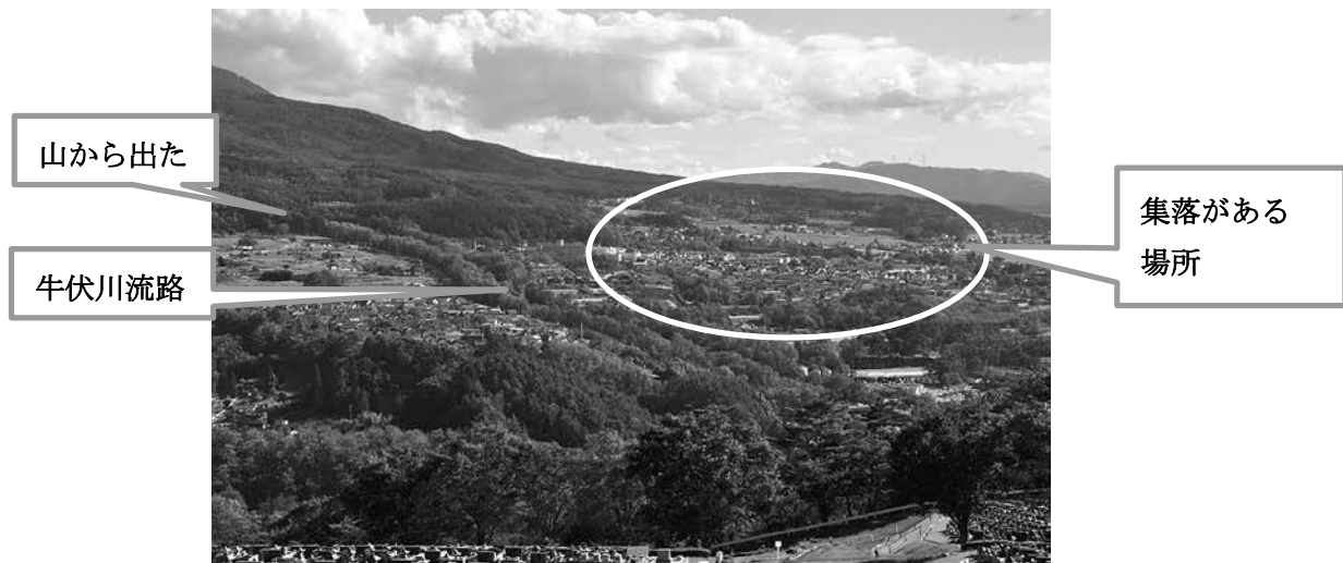
写真1.1.1 中山から望む牛伏川扇状地（現況）
