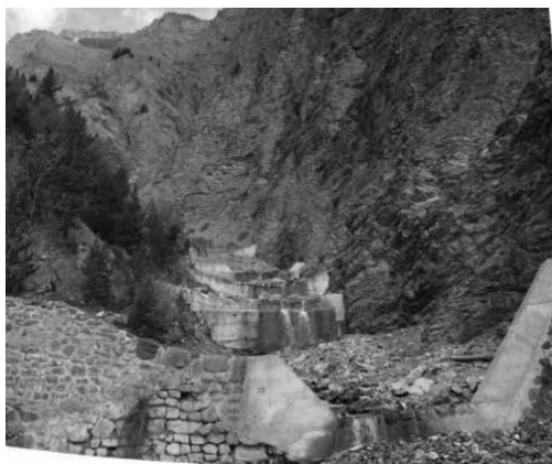
写真1.2.8 サニエル溪上流部の砂防堰堤（2004年筆者撮影）
