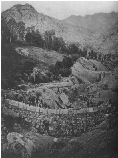
写真1.2.6 1877年、サニエル溪における建設中の砂防堰堤（Ubaye, La Foret Reconstituée, RTM、1990より）
