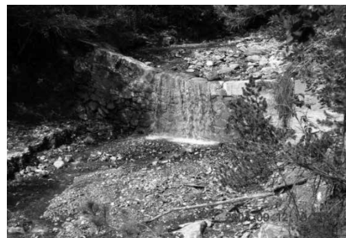
写真1.2.9 サニエル溪中流部の砂防堰堤（2004年筆者撮影）
