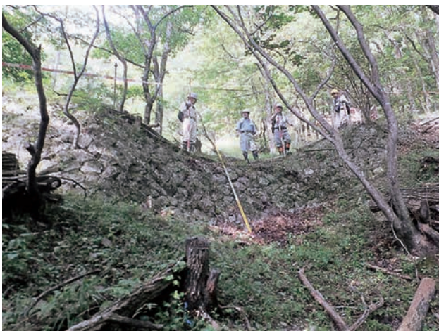
D6：泥沢中流部のえん堤 水通しが曲線状で堤長方向がアーチ状になっている。
