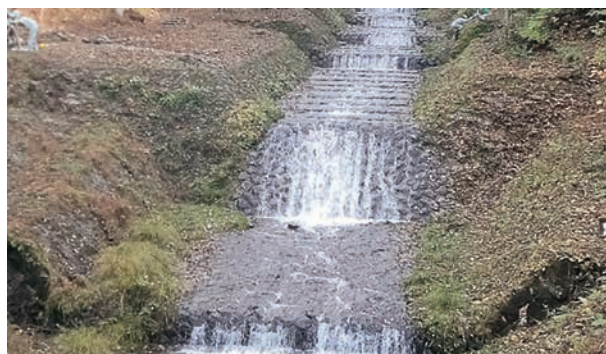
C6：最下流の根止えん堤 当初下流の水叩は沈床だったと思われる。
