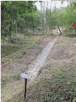
D2：泥沢の水 路張石 尾根ま で直線上に伸び ている。
