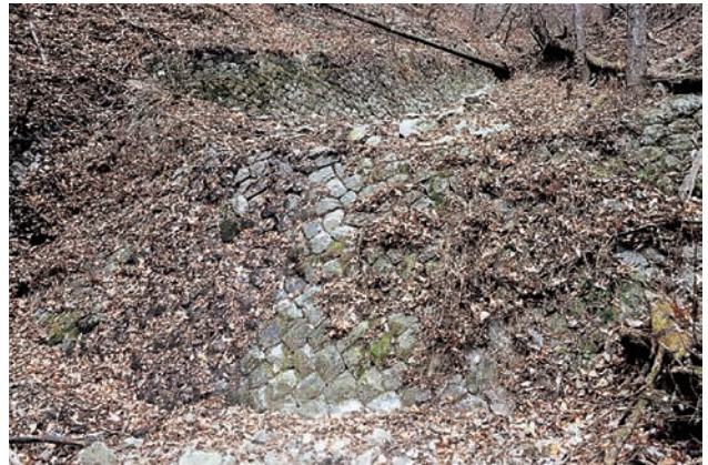
G4：悪沢のえん堤 高さに比して堤長が長く、上流の右岸に石積護岸が続いている。
