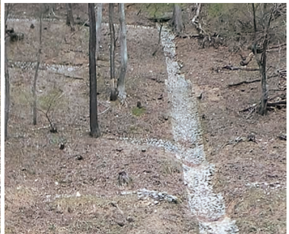
G6：水路張石が斜面上部までのび、数段には水路から横に石積連続している。
