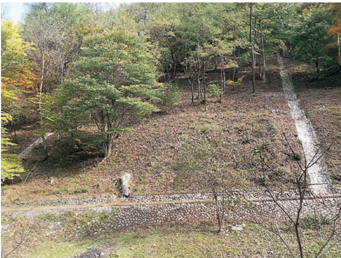
G5：悪沢合流の直上流の本流右岸斜面の現状 積苗工や水路張石の施工状況が窺える。整備直後であり、草木が繁るとみえない。
