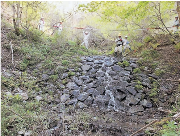
G3：小規模なえん堤 高さが低く、下流勾配も緩やかである。
