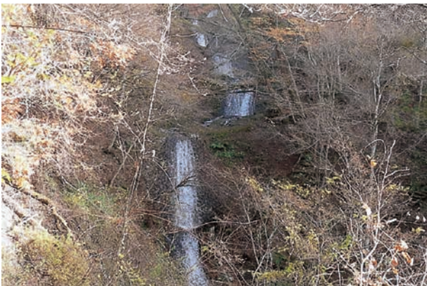
F6：杉ノ沢上流部連続えん堤群の現況 高落差を水の向きを変えながらえん堤が配置されている。
