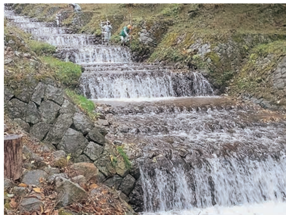
C4：水叩の小段差
