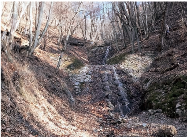
E3：日影沢と中ノ沢合流点付近から上流に連続する石積みえん堤 流向に配慮し、えん堤の向きが配置されている。
