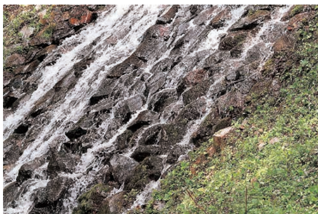
B4：内務省えん堤の石積みの状況 階段工などとは異なる。
