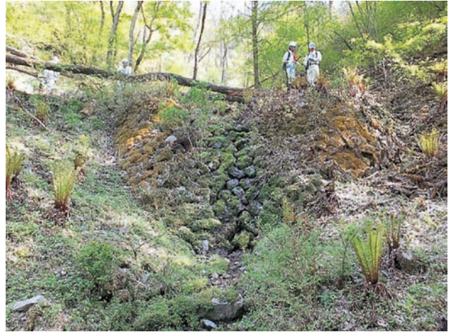
G2：支流の谷止工の石積 左右岸の取り付けの石積形状が特有である（ハート型）。
