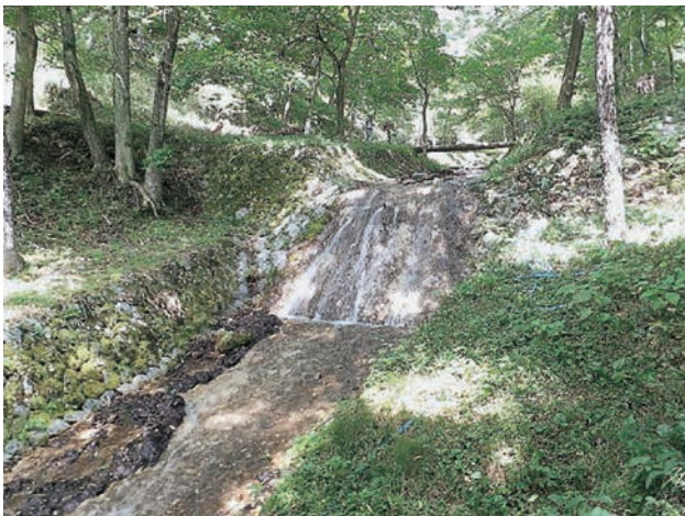
D4：杉ノ沢泥沢合流点直上流のえん堤 泥沢水路は円形の形状である。河床に沈殿する泥が沢の名称の由来とされる。
