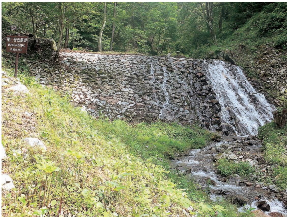
B1：内務省2号えん堤 水通しの側壁などが曲線的な特徴ある形状である。
