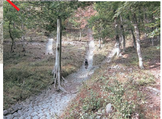
D3：泥沢中流部右岸 の水路張石 いくつかの水路が合流 している。
