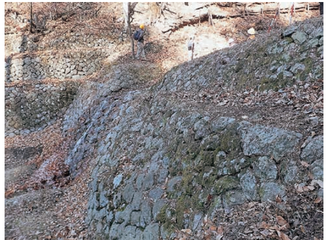
E2：横からみたE1のえん堤 右岸の斜面の裾に石積み護岸がつづく。
