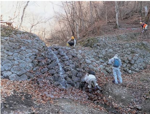
E1：日影沢中ノ沢合流点付近の石積えん堤 下流法面が2段積みになっている。
