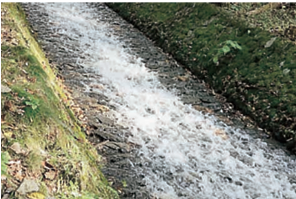
F3：F1の三面張水路の空石積 底の凹凸が水の流れを抑制、美しくしている。
