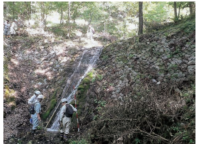
D5：泥沢中流部のえん堤 高さ5m以上と規模が大きい。副えん堤が2つ設けられ、高落差を処理している。
