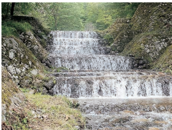
C3：階段工上部 落差を数段の床固で処理している。
