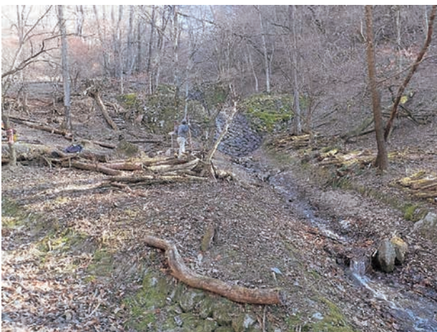
E5：地獄谷の最下流部のえん堤 破損は見られず安定している。
