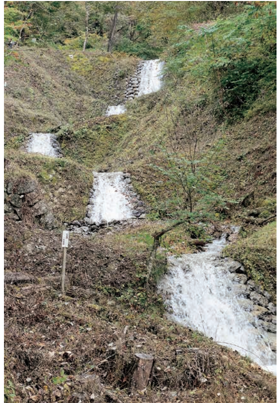
F2：直線水路の上流に位置する5段連続えん堤 落差をここで処理している。
