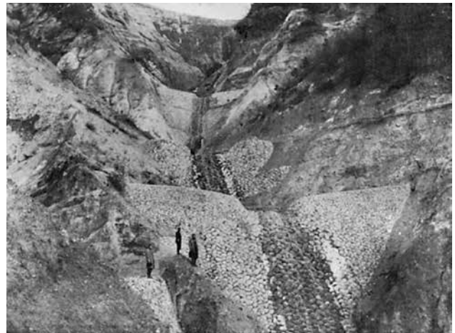
(写真28) 地獄谷石積みえん堤 (明治36年撮影)
