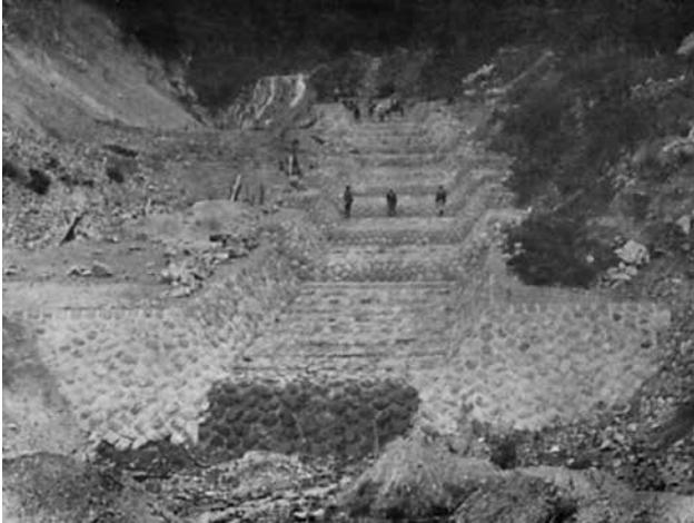
(写真7) 施工中の階段工 (大正6年9月撮影)
