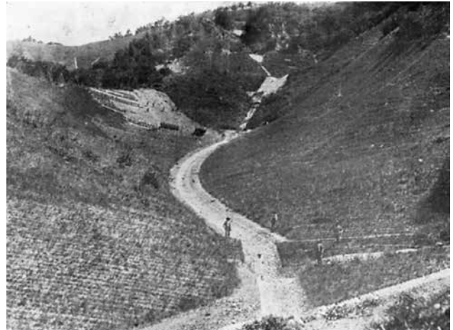
(写真26) 日影沢水路張石 (大正元年撮影)
