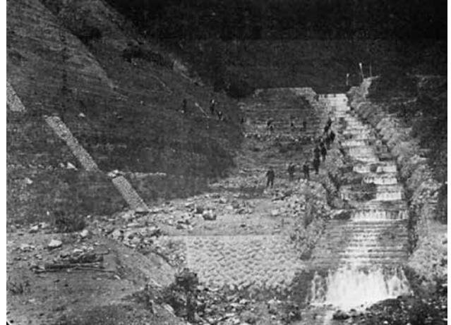
(写真8) 完成した階段工 (撮影年不明)
