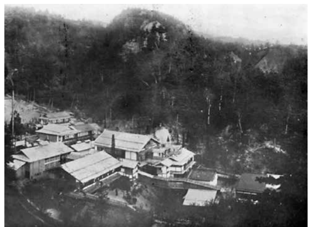
(写真6) 塩沢川水源 (昭和7年撮影)
