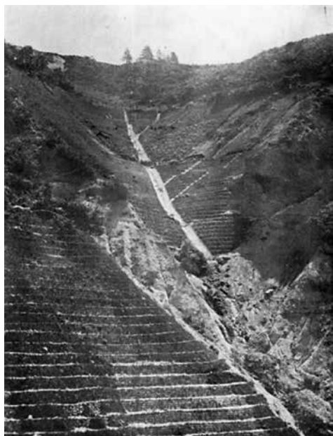
(写真31) 地獄谷 積苗工 (明治44年撮影)
