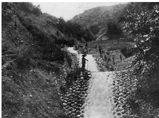
(写真34) 杉ノ沢連続えん堤群 (撮影年不明)
