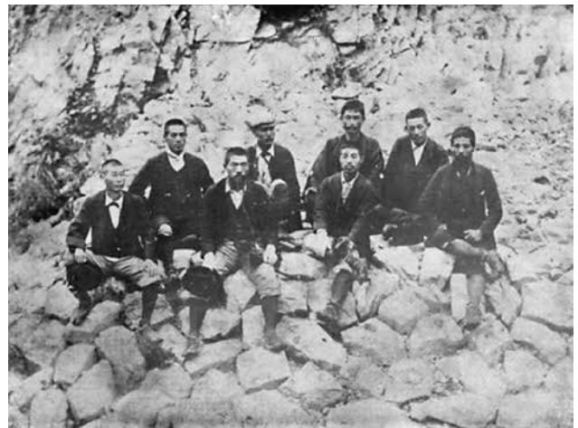
(写真20) 工事事務所県吏員 (明治35年撮影)
