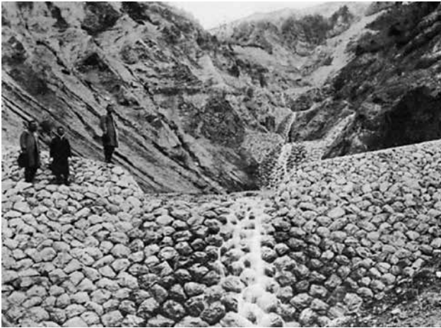
(写真25) 日影沢石積みえん堤 (明治35年撮影)
