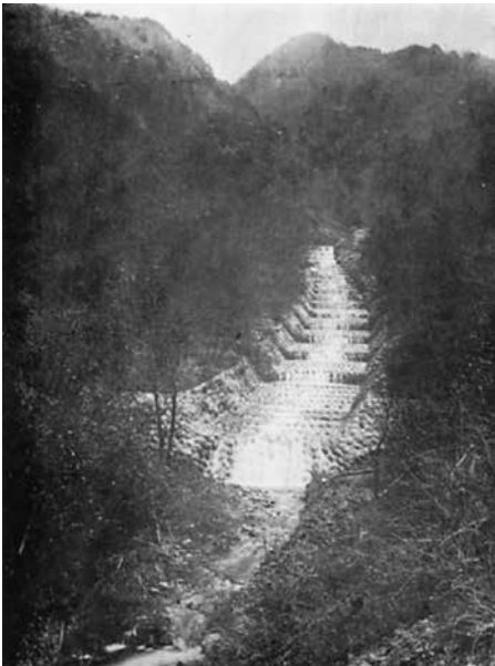
(写真9) 階段工 (昭和7年4月)
