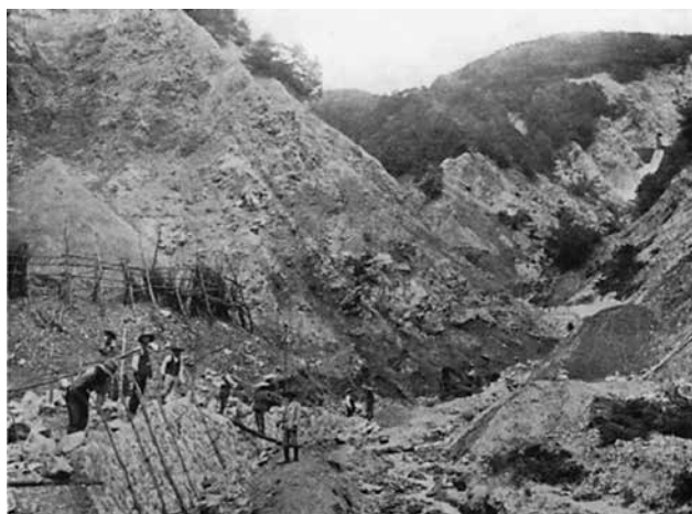
(写真33) 合清水沢護岸工 (撮影年不明)
