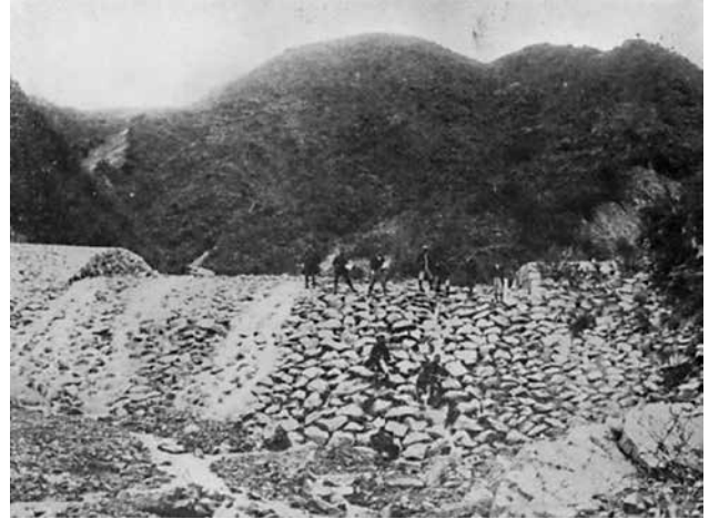
(写真2) 内務省2号えん堤 (撮影年度不明)
