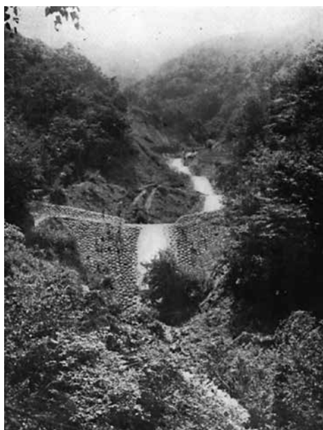
(写真35) 杉ノ沢 連続えん堤群 (明治44年撮影)
