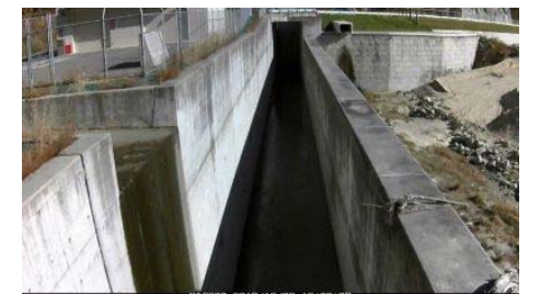
バイパス水路
