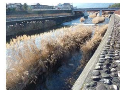
1 測点あたりの撮影箇所例
