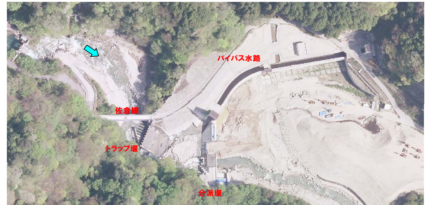
図-4.42 分派堰付近の航空写真 (平成 27 年撮影)
