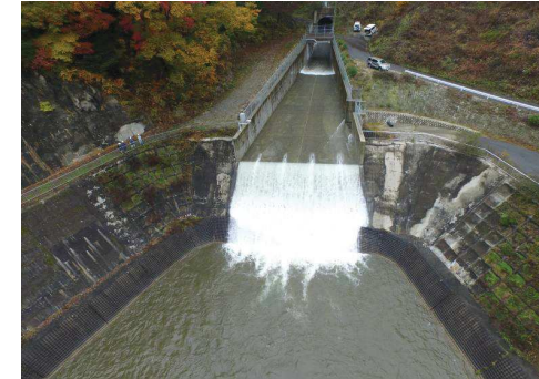
図-3.5 バイパス放流状況（バイパス放流口、H28.11.15撮影）
