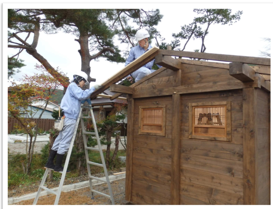
屋根作業の様子
