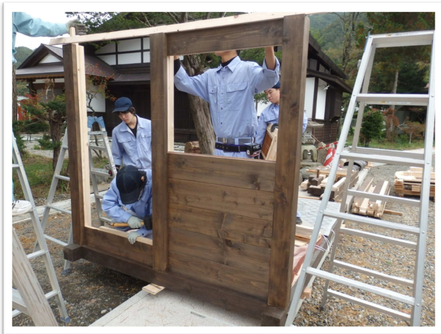
板倉造りにより壁板を落とし込みながらの作業
