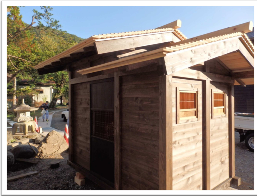
屋根仕上げ（サワラ板の重ね張り）
