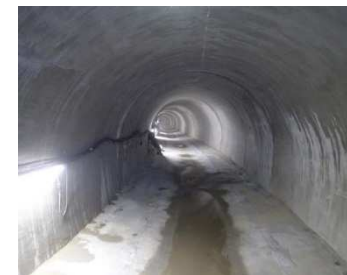
水路トンネルの更新
