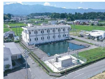
揚水機場設備の更新
