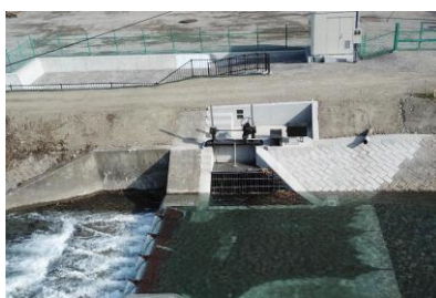
【鎖川頭首工 完成写真】
