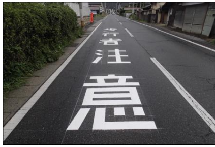
【緊急安全対策(路面標示)】
