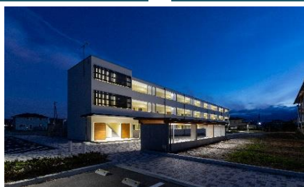
【完成した6号棟】
