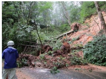
【通称:中房線で法面が崩落】
