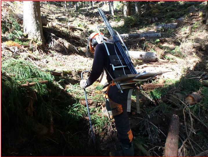
鉄筋杭人肩運搬
