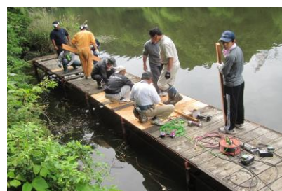
【 みどり湖栈橋補修 】
