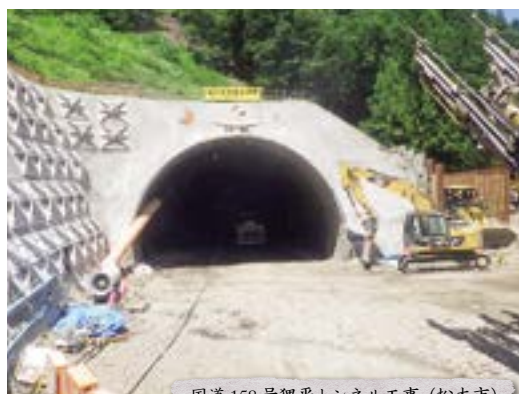
国道158号狸平トンネル工事（松本市）
