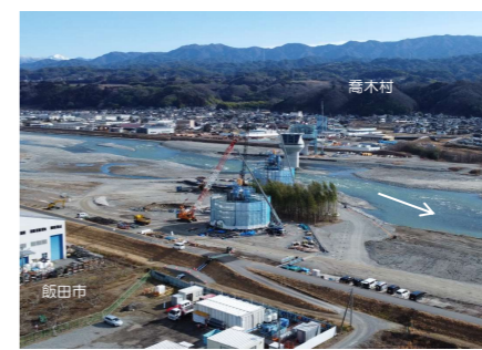
②天竜川橋梁 工事状況
