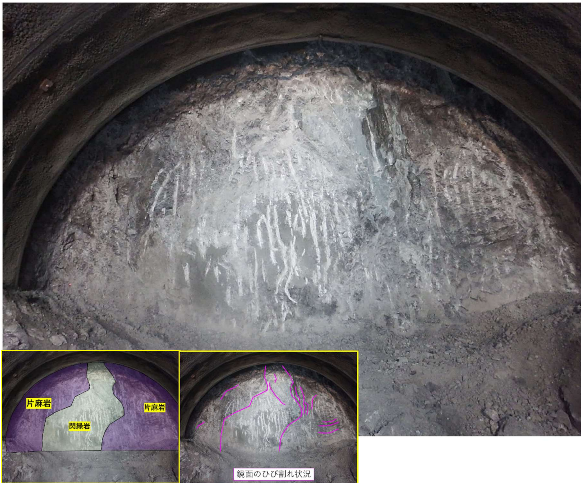
図3-5 斜坑 TD0k197.6m 鏡吹付コンクリート施工前
