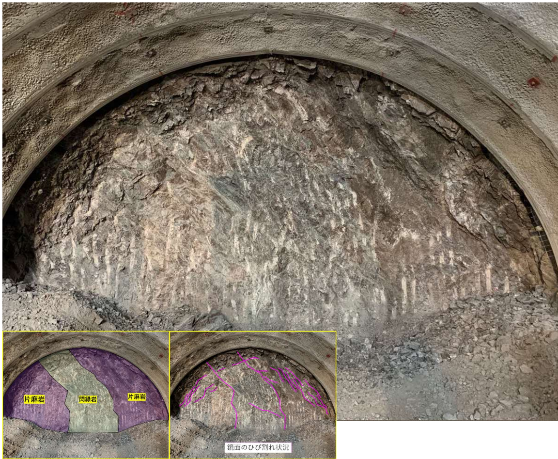
図3-3 斜坑 TD0k194. 0m 鏡吹付コンクリート施工前
