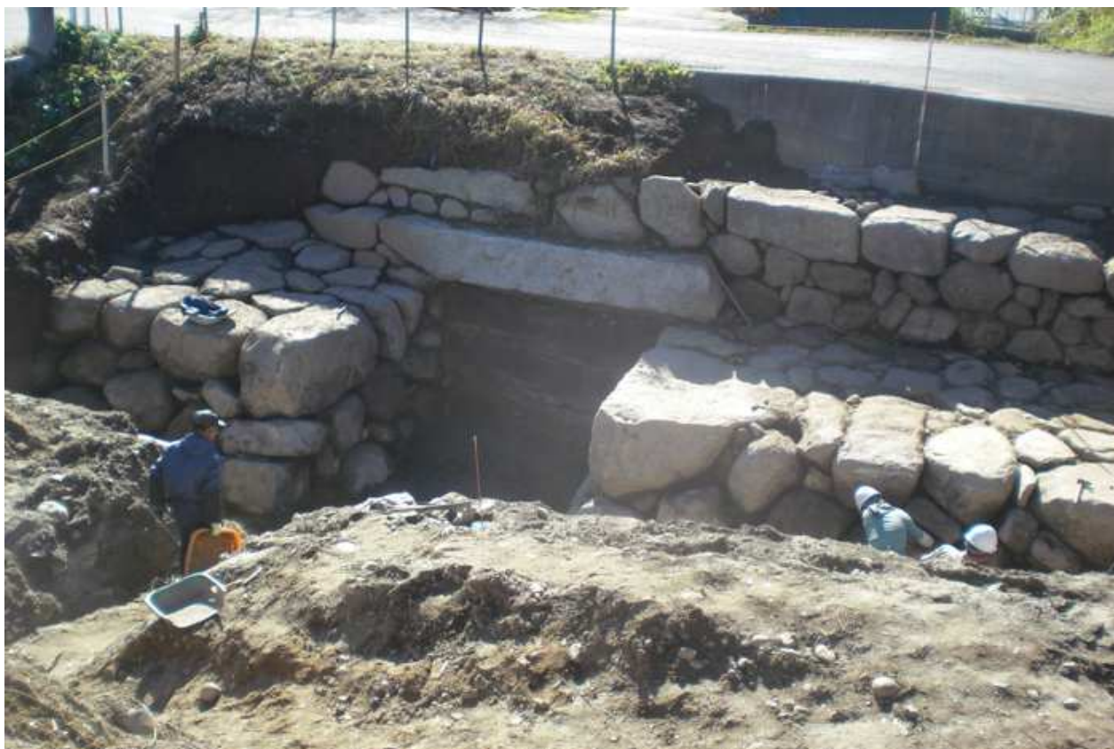
写真5 中水門 現在は機能していない
