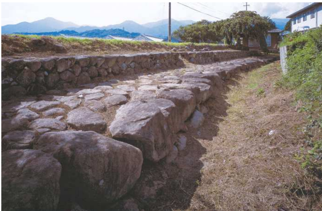
写真3 堤体：南から 上段に管理用の通路が設置された
