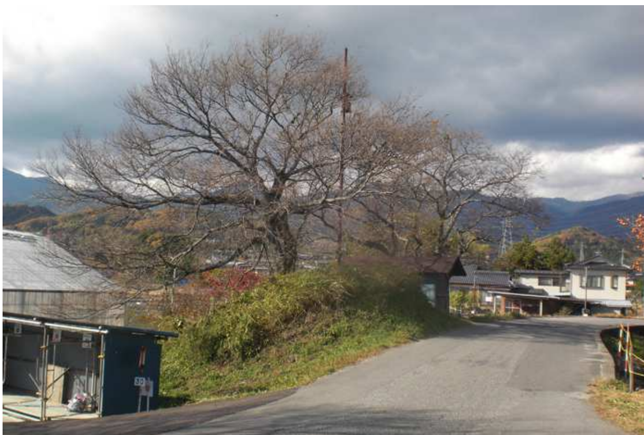
写真6 水見台 半鐘は倒壊の恐れがあったため撤去されている
