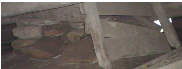
建物縁の下の囲炉裏跡
