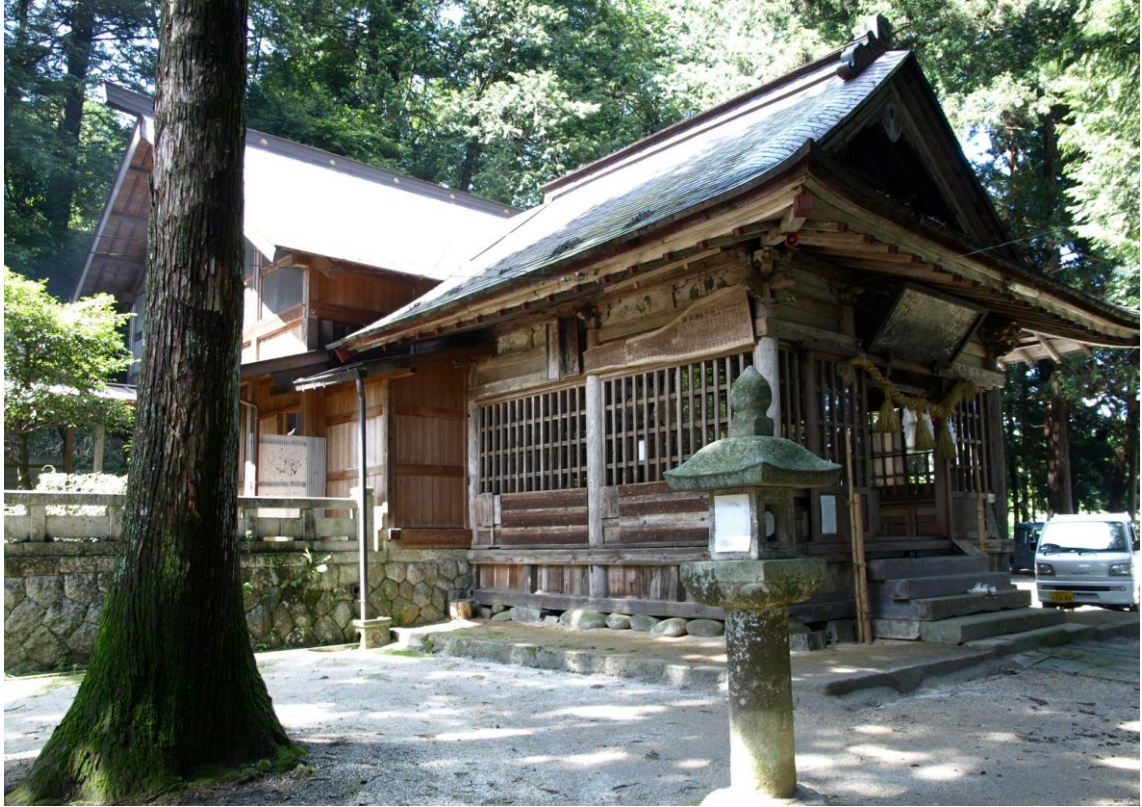
本殿覆屋 (左奥) 及び拝殿 (右)
