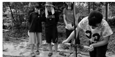
カンボジア井戸掘削作業
