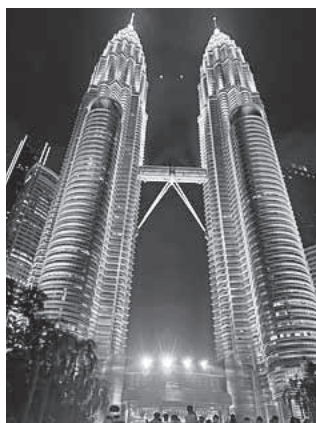
マレーシアの代名詞 ツインタワー
