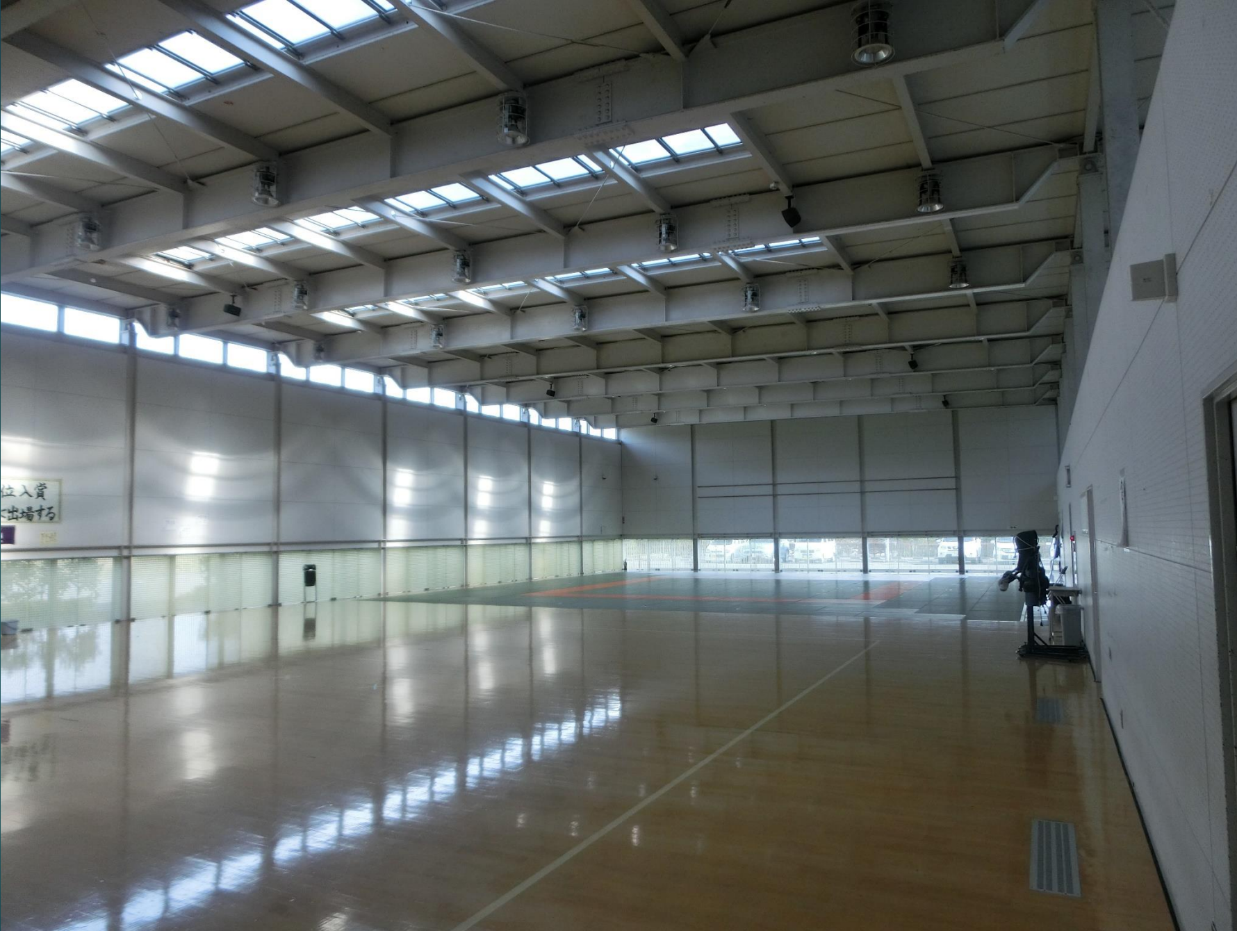
格技室 トップライトによる明るい空間
