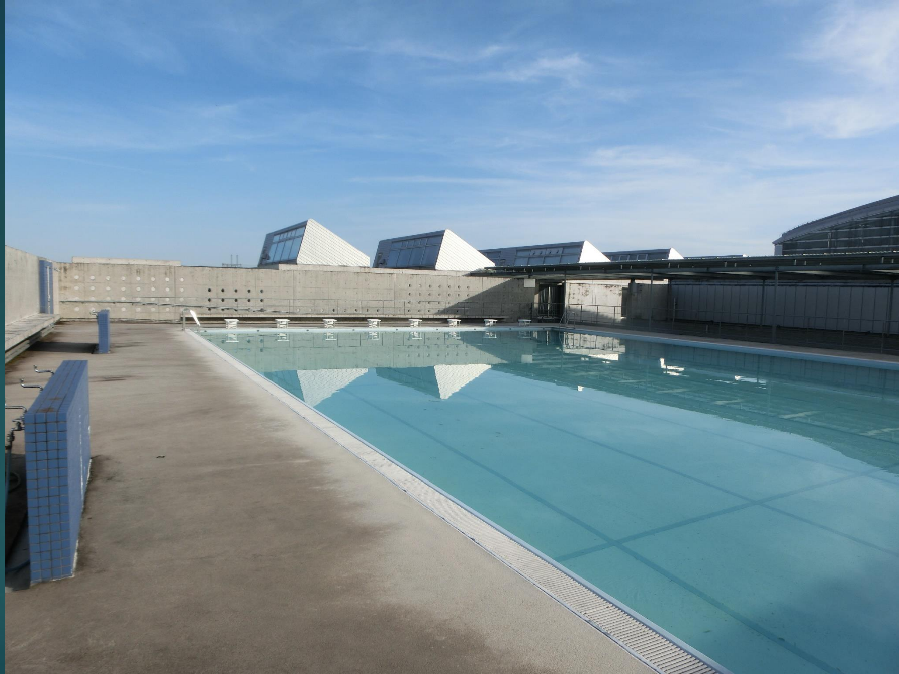
自転車置場・部室の上部にプール 奥にOMソーラーの集熱屋根が見える
