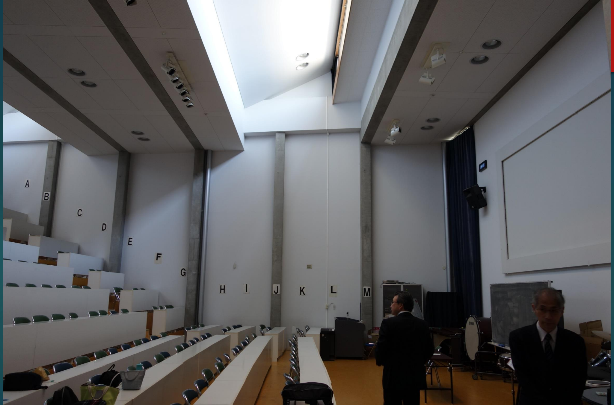
迫桜ホール ハイサイドライトによる北側からの太陽光
