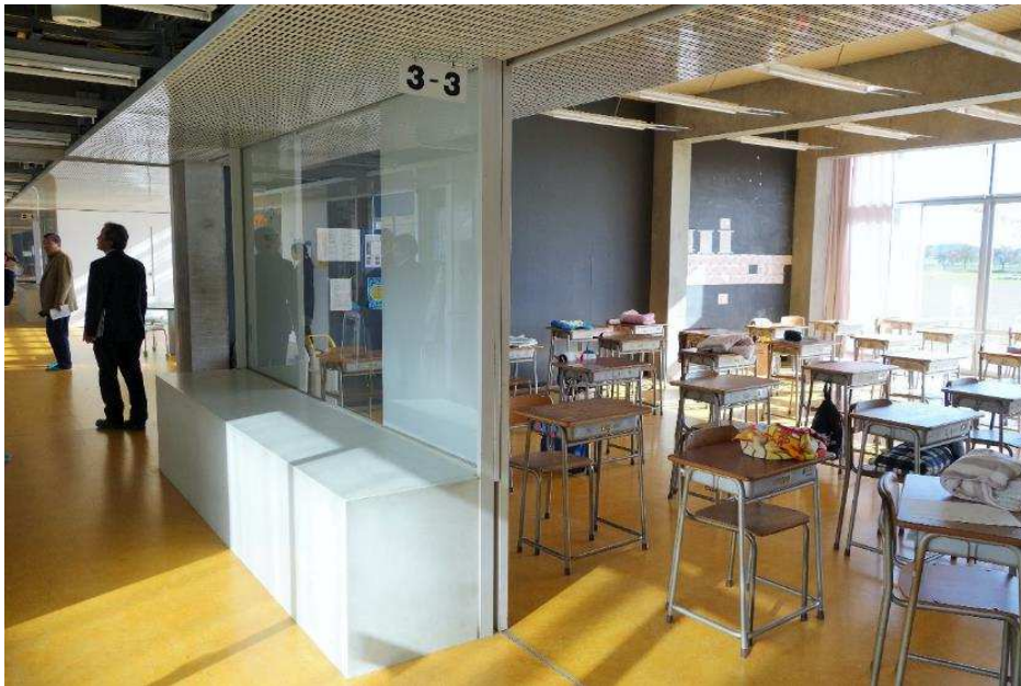
教室に可動間仕切りを設置し、他の空間と連携
