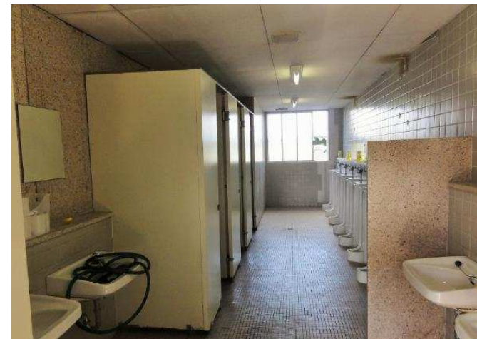
暗く快適性に乏しいトイレ
