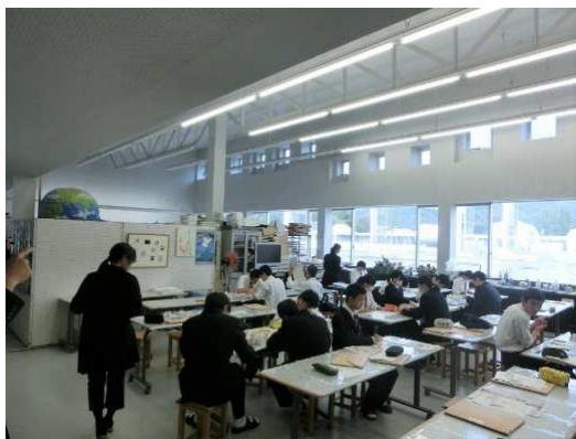
東面からのハイサイドライトによる明るい空間
