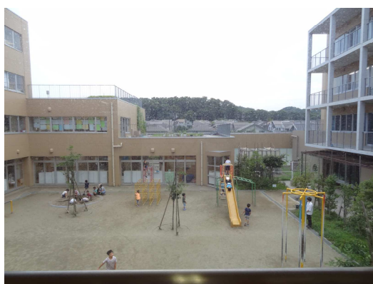
増築棟(左側建物)
