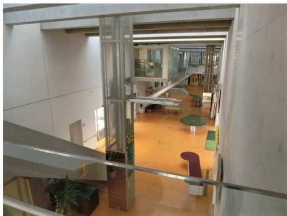
2層の FLA 縦シャフトは OM ソーラーのダクト
