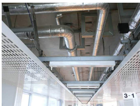
設備の変更に対応できる天井の仕上げ
