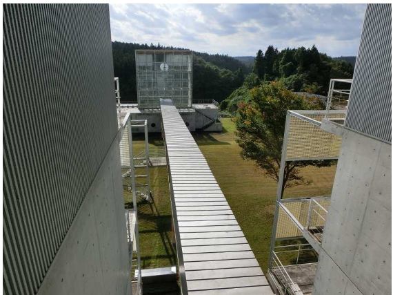
教室棟と芸術棟を結ぶ渡り廊下
