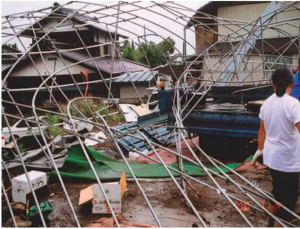
パイプハウスがねじれるように倒壊している【佐久市】
