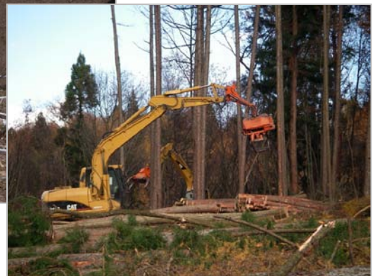
② 木の伐採状況
