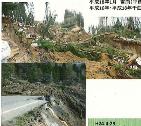
H24.4.29 融雪による地すべり災害
