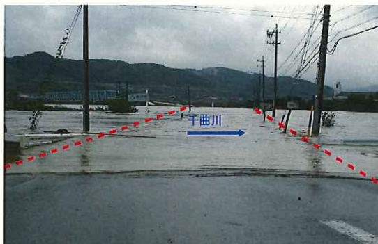
H16・H18県道の浸水被害(千曲川)
