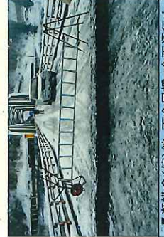
箕作飯山線 清水河原スノーエント倒壊
