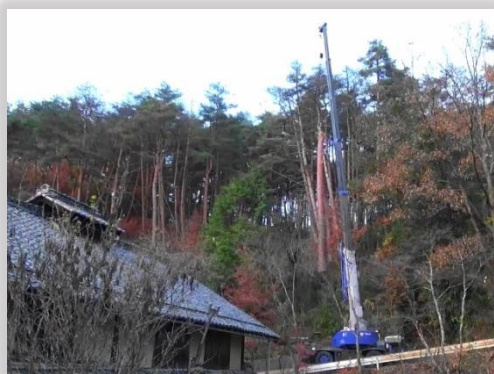
道路沿いの枯損木伐採 (松本市四賀)
