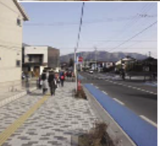
通学路の歩道整備
