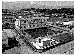
揚水機場設備の更新
