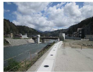
施工状況（2020年5月現在）
