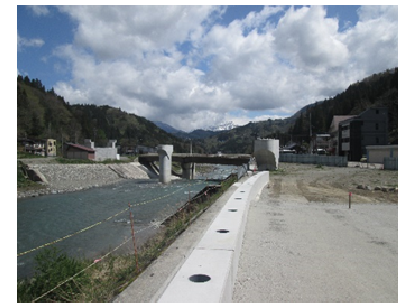
施工状況（2020年5月現在）
