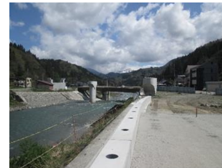
施工状況（2020年5月現在）
