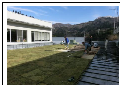
【スナゴケの屋上設置作業】
