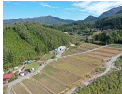
完成した上松町野尻工区のほ場
