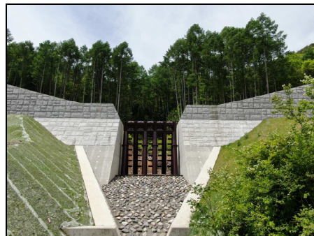
【木祖村 杣沢砂防堰堤】
