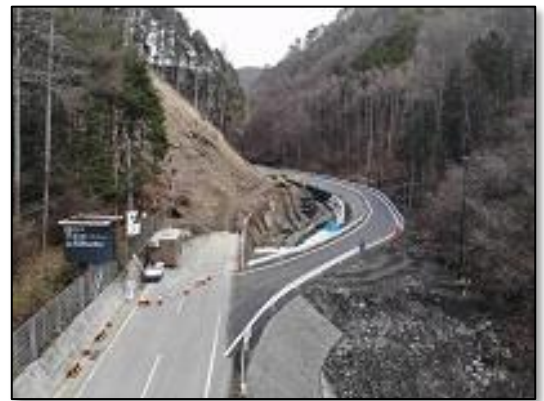
国道 361 号 地すべり現場・仮設道路
