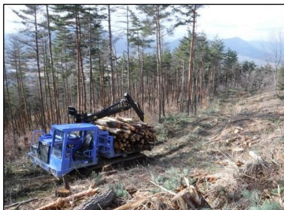
被害材の搬出状況 上田市
