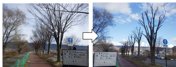
諏訪市(主) 諏訪辰野線：街路樹の剪定
