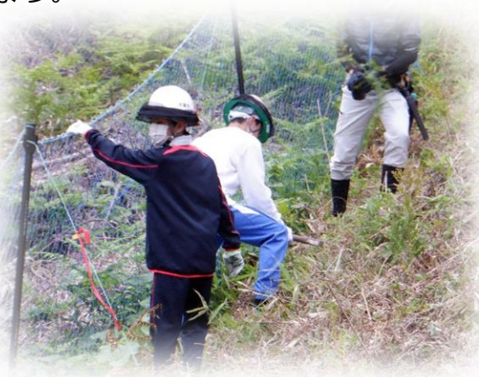
設置されている防護柵を確認
