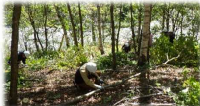
不要木の伐採作業
