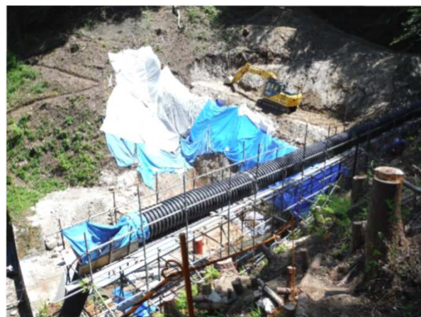
写真2 河川の流れを迂回させて土砂を掘削（谷止工施工位置）
