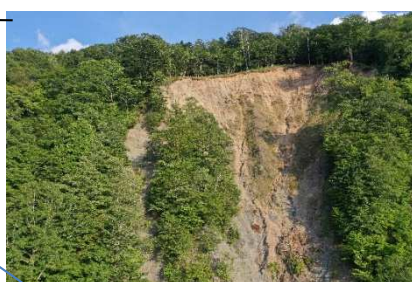
崩壊源頭部の確認
