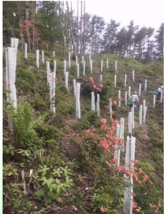
植栽と防護ネット設置が終わった山
